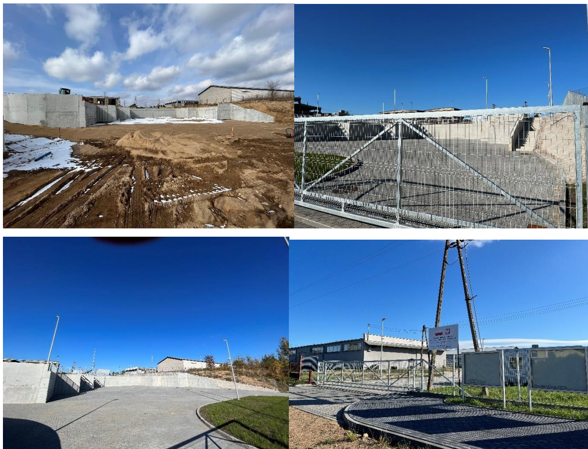
Zdjęcie 5. Budowa punktu selektywnej zbiórki odpadów komunalnych (PSZOK)
