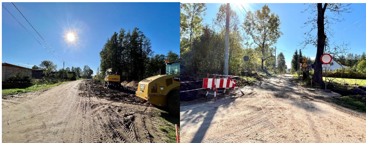
Zdjęcie 3. Rozbudowa drogi gminnej w m. Klimówka
