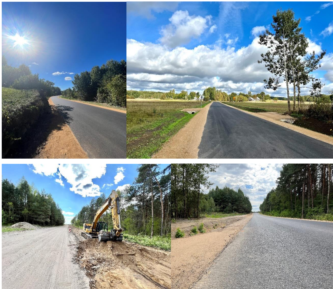
Zdjęcie 4. Przebudowa z rozbudową drogi gminnej obręb Czuprynowo i obręb Parczowce
